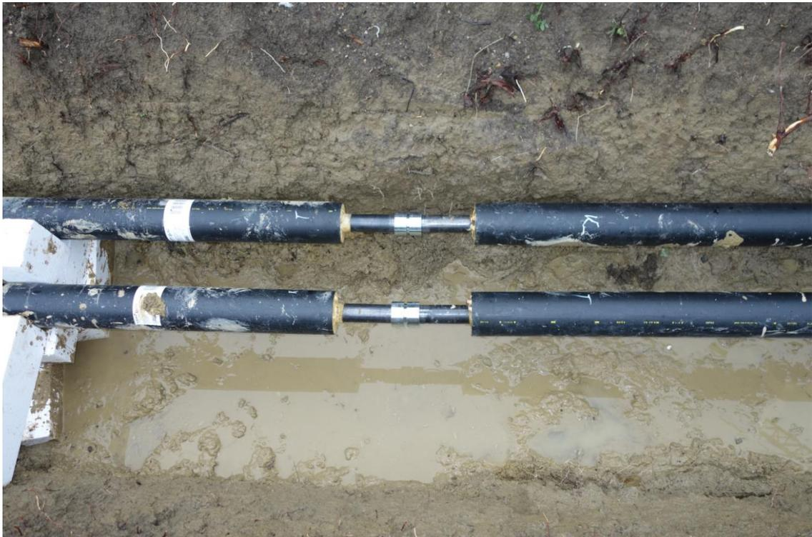
*Verpresste Verbindung Vor-/Rücklauf während Druckprobe*
