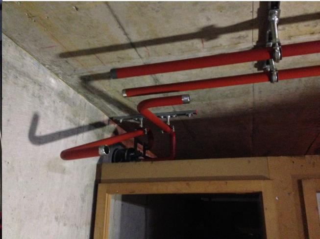
Trennen der Rohrleitungen und Vorbereitung der Rohre für das axiale Verpressen
