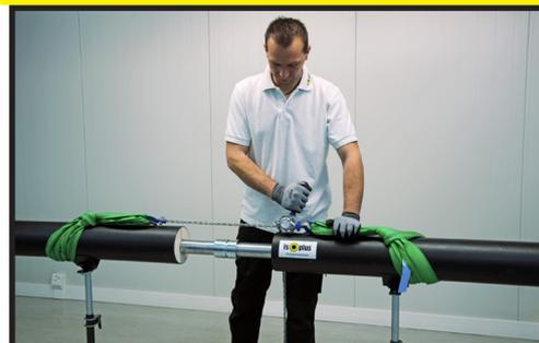
Bei größeren Rohren oder bei Arbeiten in Schräglagen empfiehlt es sich einen Seilzug zum Zusammenbau der Rohre bzw. zur Sicherung der Lage zu verwenden. Die Rohre müssen beim Zusammenfügen absolut fluchtend sein. Die Rohre dürfen erst nach der Verpressung gebogen werden.
