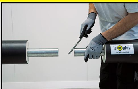
Weiters ist das Rohr innen und außen zu entgraten und wiederum zu säubern. Eine weitere Vorbereitung der Stahlrohrenden (Schweißfase) ist nicht notwendig.
