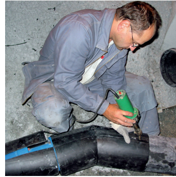
Montage und Nachdämmung.
