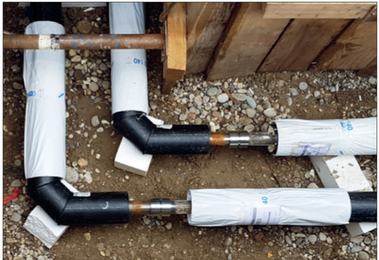
Bild 1. Das Verpressen einer Rohrverbindung dauert mit dem Haelok-Pressverbinder weniger als eine Minute und erfüllt die hohen Ansprüche an Dichtigkeit und Statik in der Fernwärme
