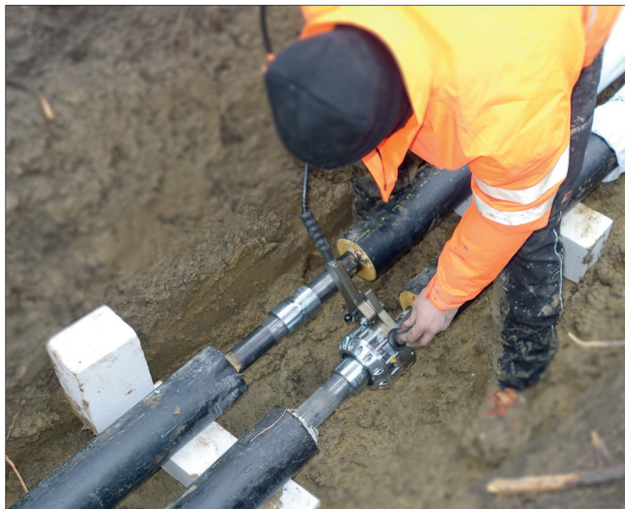
Bild 3. Einfache Handhabung auch mit in Betrieb befindlichen Leitungen: das Montagepersonal kann in sicherer Umgebung risikofrei die Verbindungen durchführen
